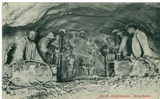
Abb. 1. 1897. Arbeiter bei den Bohrarbeiten. Photoglob, Zürich.
