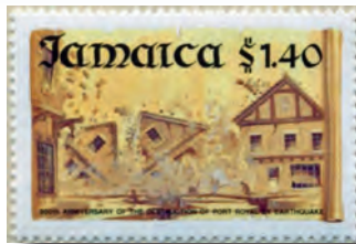
Zerstörung von Häusern und Strassen.
